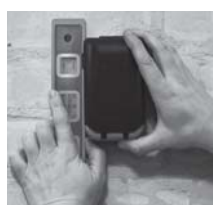
水準器で製品が垂直になっていることを確かめます。
